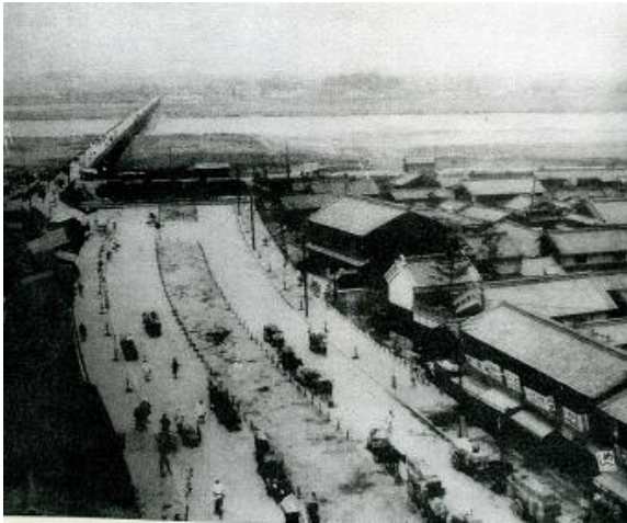
新淀川に架かる西成大橋と国道二号線
