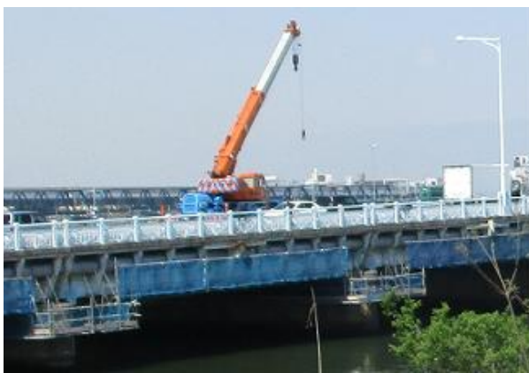
工事中の淀川大橋
