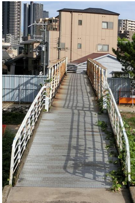
撤去直前の「鷺洲二之橋」
