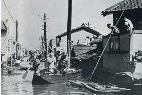
『第二室戸台風災害誌』より
