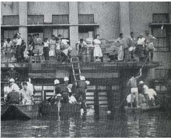
『第二室戸台風災害誌』より
